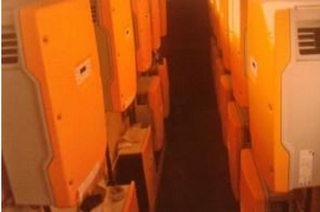
**In una seconda fase del progetto venne realizzata l'installazione degli inverter sulla copertura, per trasformare la corrente continua prodotta dai moduli fotovoltaici in corrente alternata e quindi, tramite adeguata cablatura, permetterne il trasferimento alla cabina elettrica di trasformazione ubicata nella parte basamentale dell'aula, al fine di alimentare, oltre all'aula stessa, le zone del Vaticano ad essa limitrofe.**
