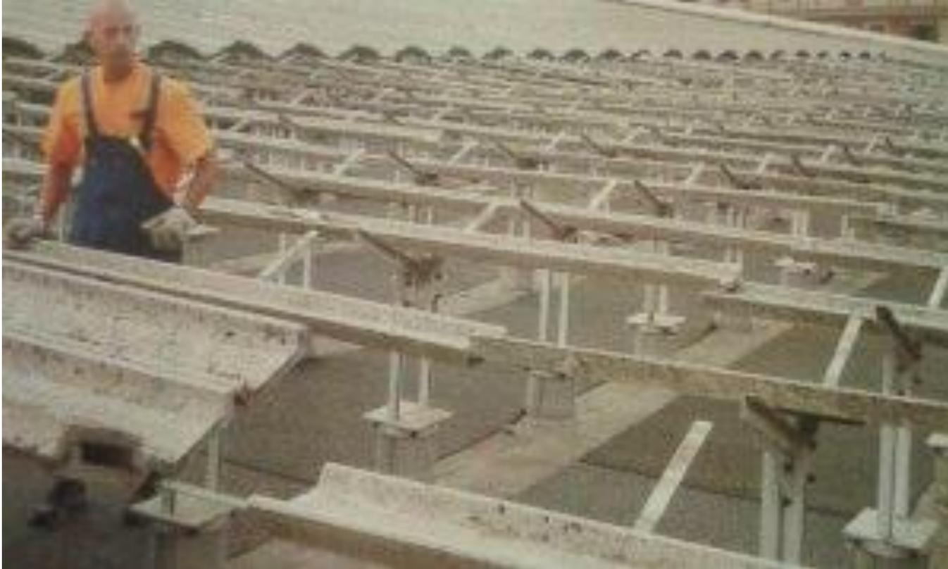
La prima fase del progetto consisteva nella asportazione di tutti i 4800 elementi ombreggianti in calcestruzzo di cemento armato, sostituendo la metà la cui superficie era rivolta verso sud con moduli fotovoltaici, e l'altra metà che invece era orientata verso nord, con pannelli di alluminio semi riflettenti, in modo da aumentare l'efficienza produttiva dei pannelli fotovoltaici aumentando l'intensità dell'effetto di irraggiamento solare sui moduli fotovoltaici.
